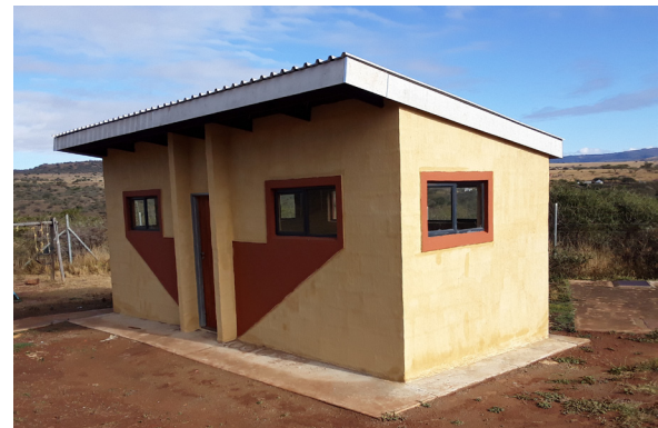
Die sanitären Anlagen für die Kinder
