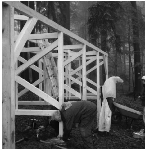
die neue Hütte im Wald entsteht
