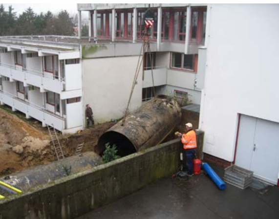
Entfernung der alten Tanks
