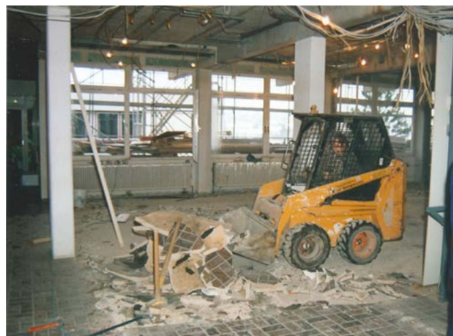
1995 startet der 2. Umbauabschnitt
