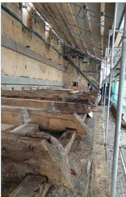
Dachbalken vor der Sanierung. Foto: KST
